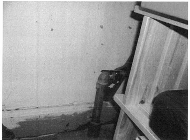
Billede 14: Tæret fitting og overgang galvaniseret til
