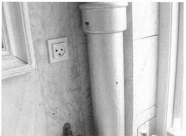
Billede 16: Tæring på faldstamme i badeværelse.
