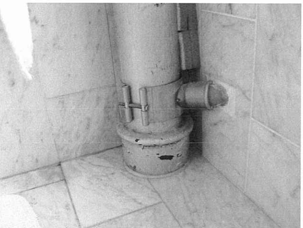
Billede 17: Tæring på faldstamme i badeværelse.
